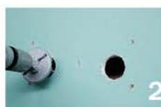
2 Percer 5 trous de fixation en  $\varnothing$  8 mm. Prendre le centre de la serrure comme repère et percer 2 trous d'alimentation en  $\varnothing$  50mm.
