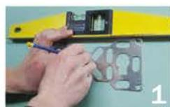
1 A l'aide d'un crayon et d'un niveau marquer l'emplacement des 5 trous de fixation et des 2 trous accueillant les raccords soudés.
