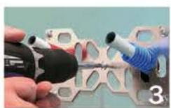
3 Faire apparaître le tube multicouche. Positionner la platine contre la cloison, élargir les chevilles en les vissant puis retirer les 5 vis.
