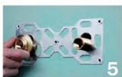
5 Faire descendre les raccords sur la platine. Visser les contre-écrous manuellement puis terminer le serrage à la clé.
