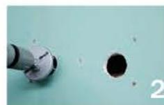
2 Percer 5 trous de fixation en  $\varnothing$  8 mm. Prendre le centre de la serrure comme repère et percer 2 trous d'alimentation en  $\varnothing$  50mm.
