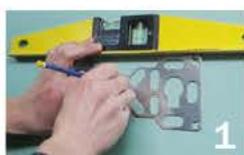
1 A l'aide d'un crayon et d'un niveau marquer l'emplacement des 5 trous de fixation et des 2 trous accueillant les raccords coudés.
