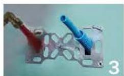
3 Faire apparaître le tube PER gainé. Positionner la platine contre la cloison, élargir les chevilles en les vissant puis retirer les 5 vis.
