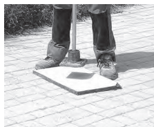
Compacter en utilisant une plaque protégée par un feutre.
