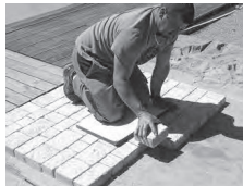
Déplacez-vous à l'aide d'une planche sur les pavés déjà posés.
