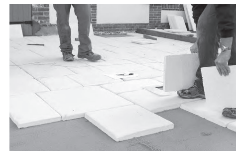
Mise en place des dallages (ici des dalles Castellane multifomat) sur lit de sable parfaitement de niveau.
