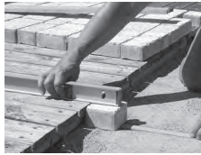
Vérifier la parfaite planéité du support lors de la pose des premiers pavés.
