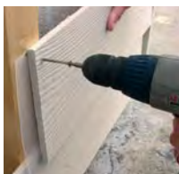
④ Ne pas oublier la bande à joint sur le chevron à la jonction de 2 clins
