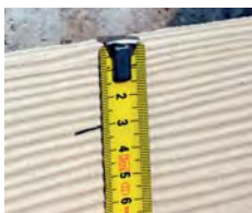
③ Recouvrement de 30 mm
