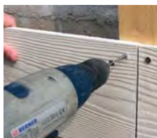
④ Ne pas oublier la bande à joint sur le chevron à la jonction de 2 clins
