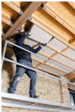
Mise en place entre chevrons.
