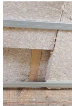
Recouvrement des chevrons pour éviter les ponts thermiques.
