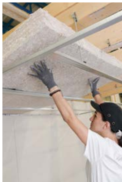
Mise en place de l'isolant sur ossature métallique.
