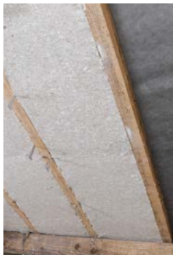
Mise en place aisée en rampants grâce à la légèreté des panneaux.
