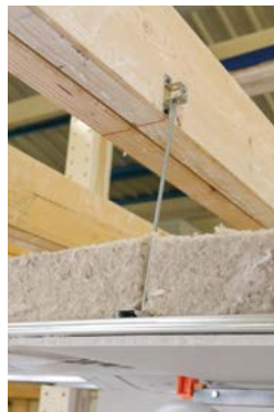
Découpe facile pour le passage des suspentes et la continuité de l'isolation.
