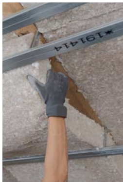
La flexibilité permet une mise en place au travers de l'ossature.
