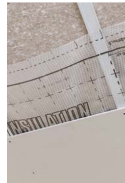
La mise en place du pare-vapeur est obligatoire. Sa valeur Sd doit être > 18 m en climat de plaine et > 57 m en climat montagne.
