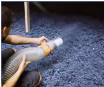
Le matériau est mis en oeuvre par soufflage pneumatique sur la surface d'un plancher ou entre solives ou solivettes d'un plafond suspendu à ossature apparente.
