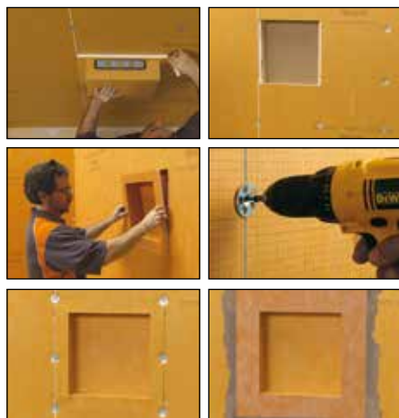
Mise en œuvre dans KERDI-BOARD
