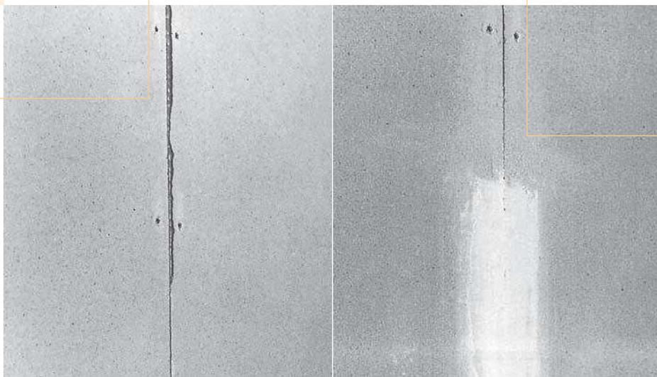
La largeur de joint ne doit pas excéder 1 mm.
