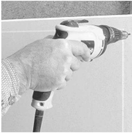
**Vissage sur une ossature métallique**
