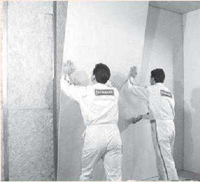
**Pose d'un parement sur une ossature métallique**
