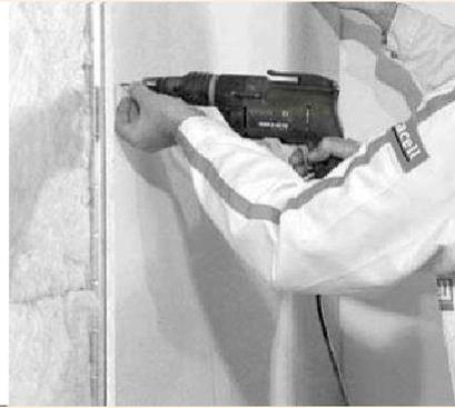
**Fixation du parement par vis auto-perceuses**
