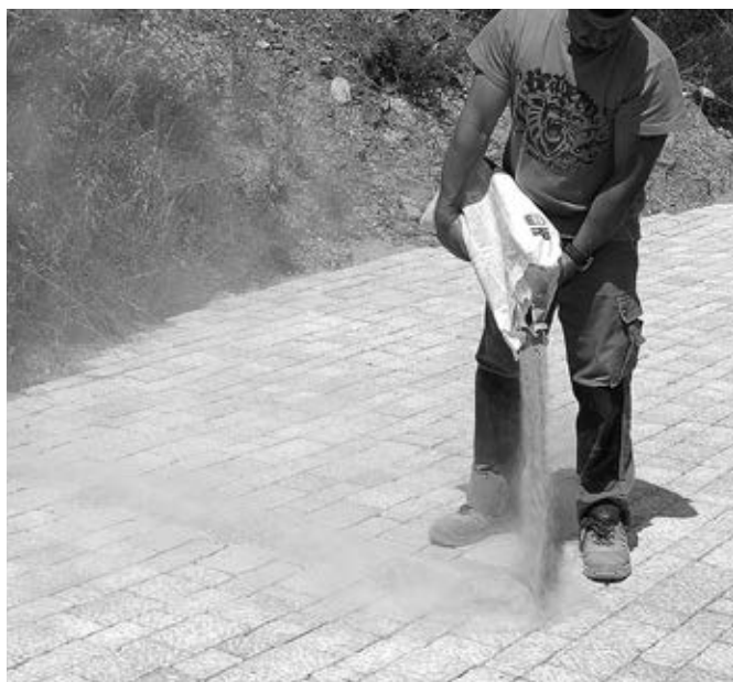
Utiliser un sable fin versé directement sur la surface pavée.
