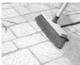
Veiller à bien faire pénétrer le sable dans les joints à l'aide d'un balai, puis compacter pour assurer une bonne pénétration du sable.
