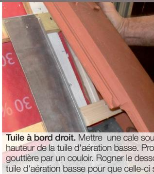
**Tuile à bord droit.** Mettre une cale sous le rabat au nez pour l'ajuster à la hauteur de la tuile d'aération basse. Prolonger l'emboîtement du rabat à la gouttière par un couloir. Rogner le dessous de la baguette d'emboîtement de la tuile d'aération basse pour que celle-ci s'emboîte parfaitement.
