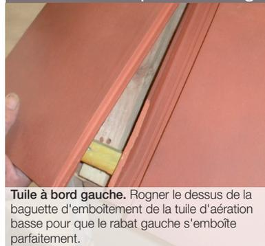
**Tuile à bord gauche.** Rogner le dessus de la baguette d'emboîtement de la tuile d'aération basse pour que le rabat gauche s'emboîte parfaitement.
