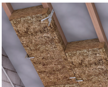
3 Pliage de l'ailette pour le maintien.
