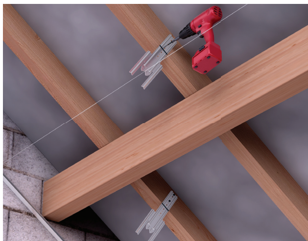
1 Marquage et fixation de la suspenste.
