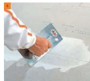
Procéder à l'assemblage des plaques de sol par rangées successives en prenant soin de décaler les joints entre plaques d'une rangée à l'autre d'au moins 20 cm.
