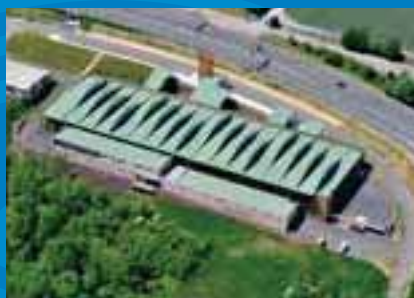
L'Arténium de Ceyrat près de Clermont-Ferrand, une construction exemplaire étanchée avec les produits SOPREMA.
